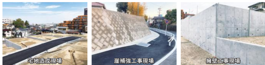
「GMトランス」で手掛けた施工実績の一例
